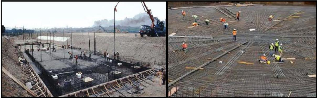
**Figure 3.4.** Exemple de coffrage et ferrailage de radier
