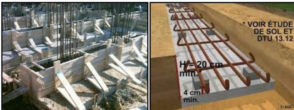
Figure 3.3 : Exemple de coffrage et ferrailage de fondations
