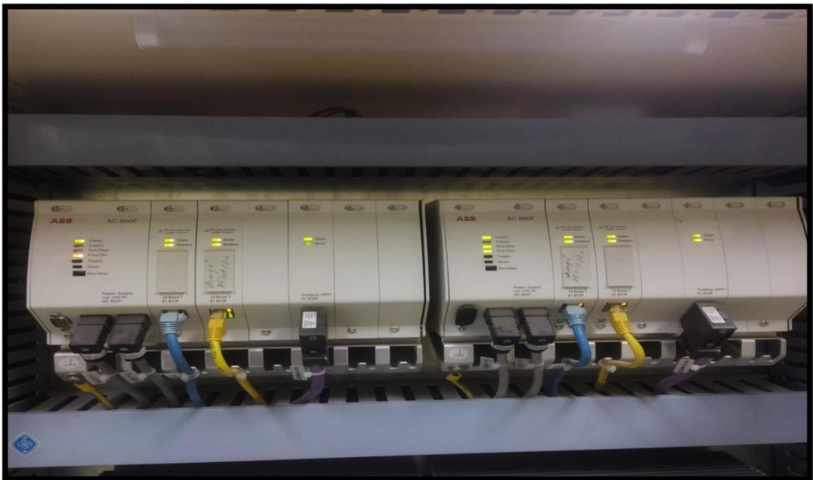
Figure III.5 Redondance de contrôleur AC 800F.[2]
