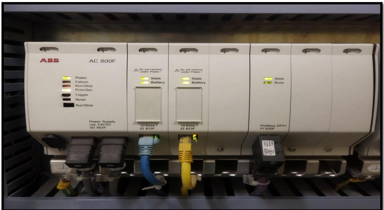
Figure III.6: Contrôleur AC 800F
