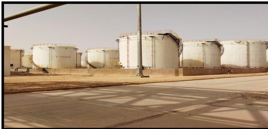
**Figure.I.19** bac de stockage pour produit pétrolier
