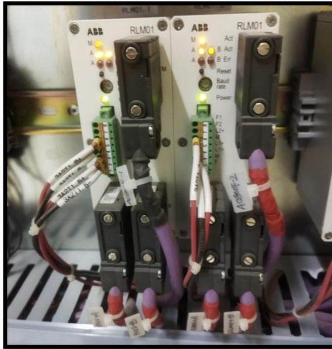
**Figure III.13:** Le module RLM
