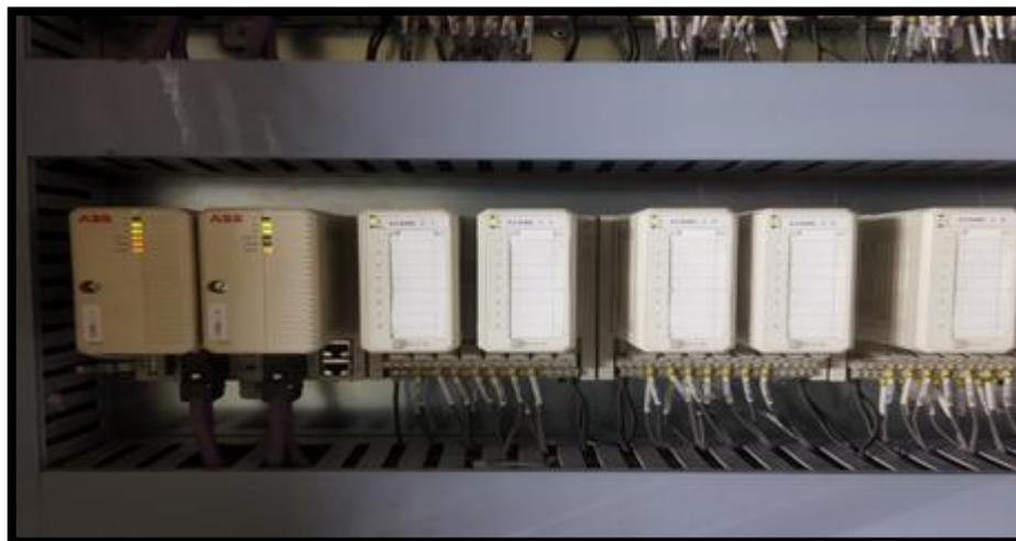
**Figure III.14:** Module d'entrées sorties S800
