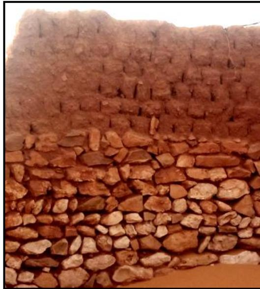
**Photo II. 2 :** Mur en Toub avec un soubassement de 1m de hauteur en pierre, Adrar.
