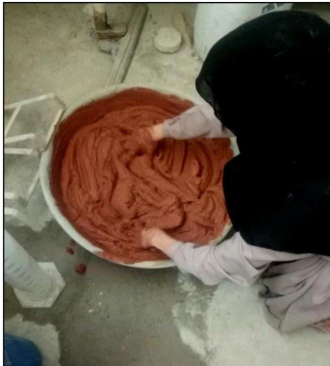
**Photo V. 5** : Préparation de la pâte du mortier pour la construction des murets.
