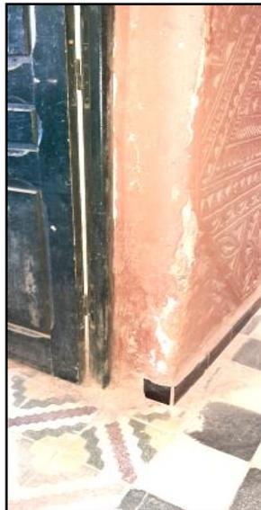
**Photo III. 2 :** Dégradation des extrémités du mur à proximité des ouvertures, CAPTerre, Timimoune, Algérie.
