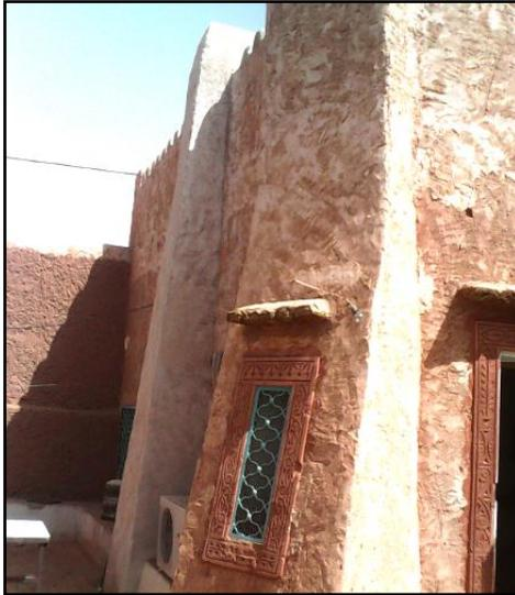
**Photo II. 13 :** Construction en adobe avec des murs porteurs réalisée en 2001, Timimoune, Algérie.
