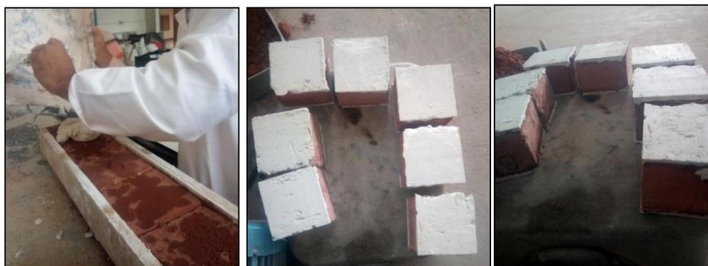
**Photo IV. 10 :** Surfaçage des adobes par une couche de 1cm de plâtre.
