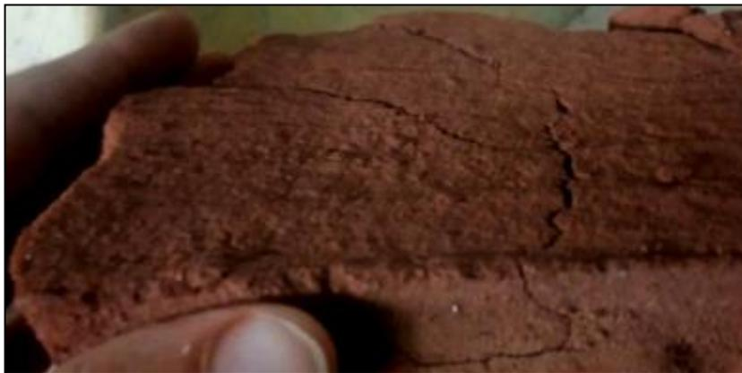
**Photo V. 15 :** Fissuration des interfaces brique – mortier.
