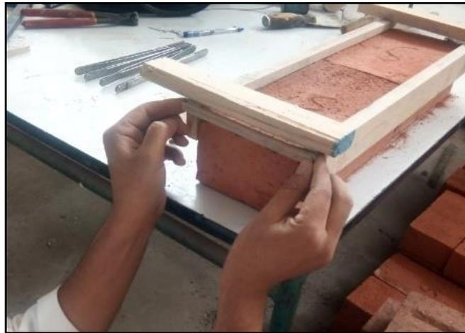
**Photo V. 4 :** Gabarit en bois fixant l'épaisseur du joint de mortier.
