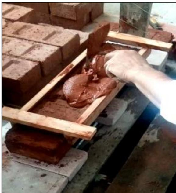
**Photo V. 8 :** Etalement du joint de mortier à l'aide du gabarit en bois.
