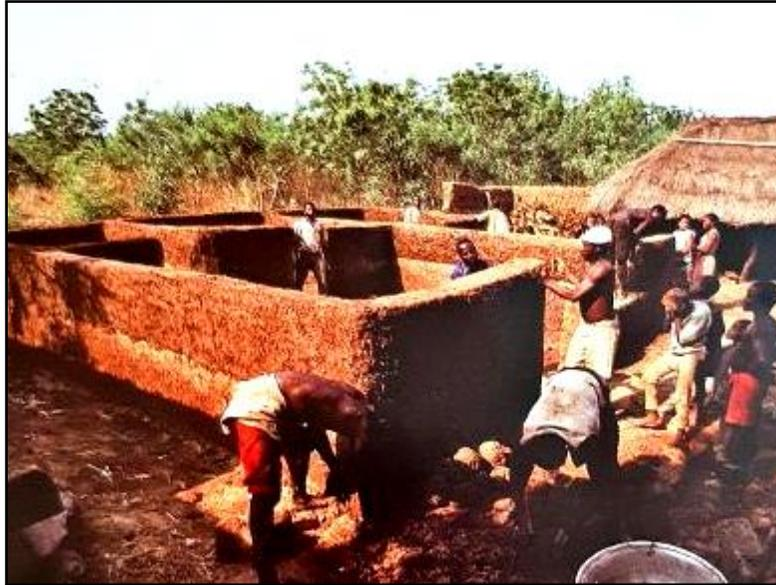
**Photo I. 9 :** Construction d'un mur en bauge, Gaoua, Pays Lobi, Burkina Faso (Terki Y., 2013)
