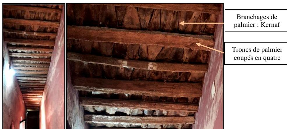
Photo II. 8 : Plancher avec une ossature principale en troncs de palmier et une ossature secondaire en branchage de palmier appelé « kernaf », CAPTerre, Timimoune, Algérie.
