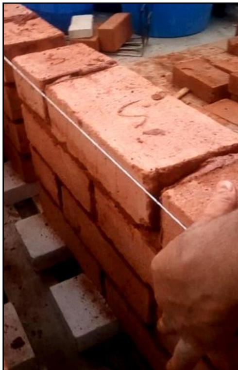
**Photo V. 7:** Placement du fil à plomb pour assurer la planéité du muret.
