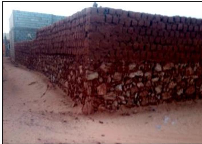
**Photo II. 4 :** Mur de clôture en adobe avec un soubassement en pierre, Timimoune, Algérie.
