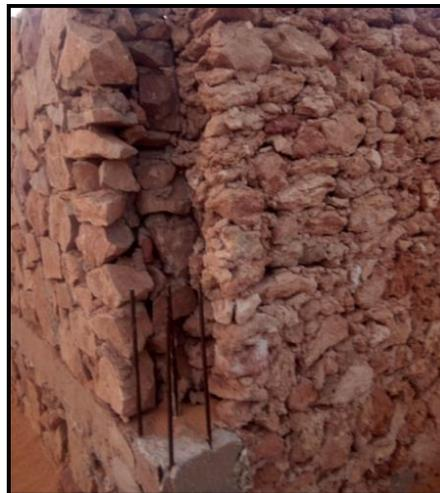
**Photo II. 14:** Mur d'une construction en adobe en cours d'exécution, avec un système porteur en béton et un soubassement en pierre, Timimoune, Algérie.
