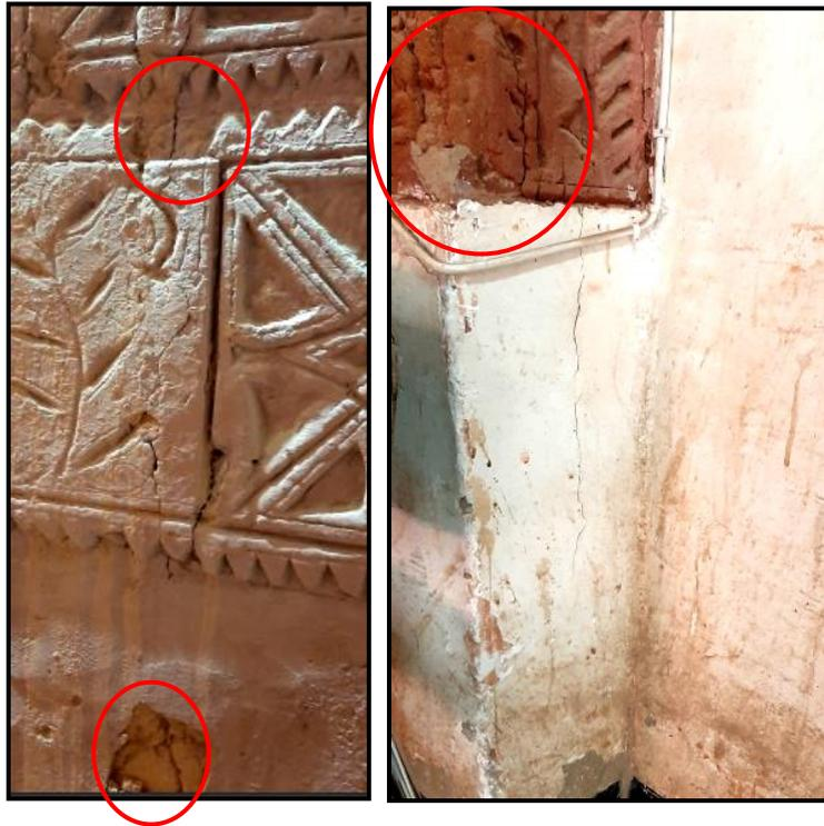
**Photo III. 1 :** Fissuration du mur due à l'action d'eau et apparition sur l'enduit en terre.
