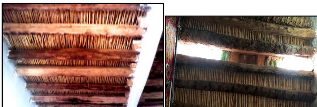
Photo II. 9 : Plancher avec une ossature principale en troncs de palmier et une ossature secondaire en « Gsab ».
