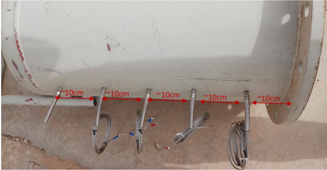
Photo 24 : Emplacement des thermocouples
