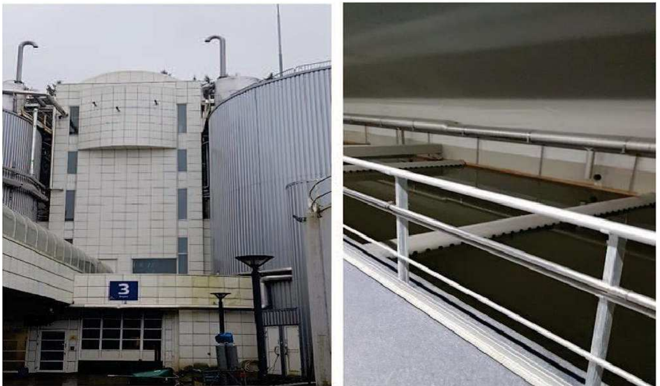
Photo III 6: Usine de biogaz IVAR, Randaberg (Norvège)
