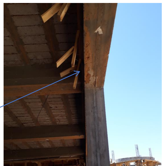
Photo 2.26. Coulage sur une couche de sable.
