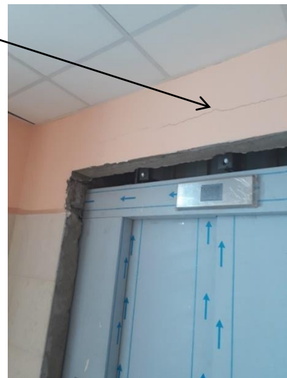
Photo 2.43., et 2.44. Fissure au-dessus du linteau.
