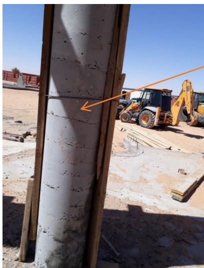
Photo 2.23. Désordres sous armatures.
