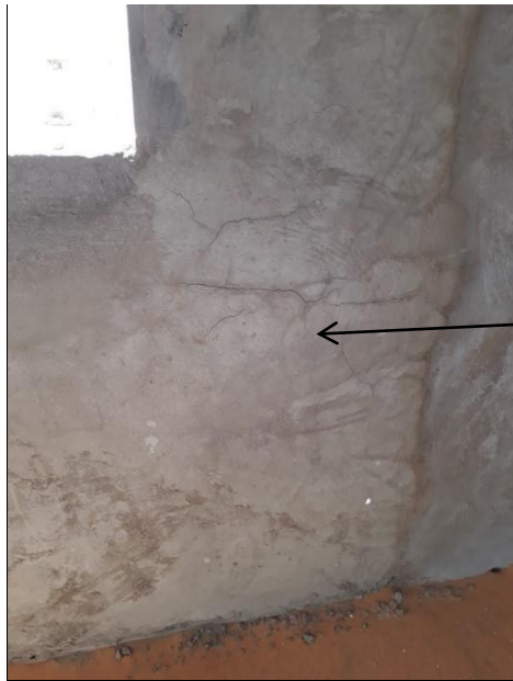
Photo 2.47. Fissures des enduits.
