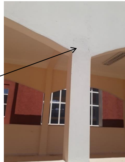
Photo 2.42. Reprise de bétonnage.
