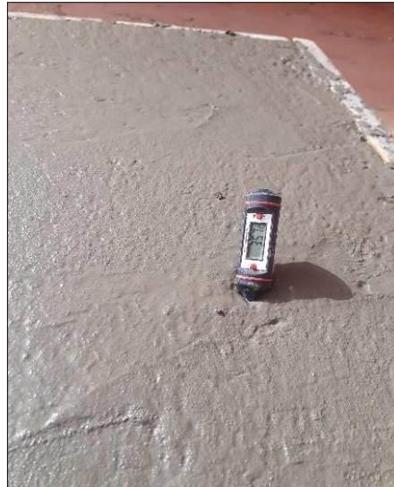
Photo 4.1. Mesure de température du béton frais
