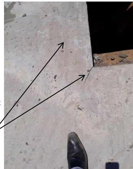
Photo 2.29. Fissure suivant le joint de dilatation. Photo 2.30. Retrait dans le béton du plancher
