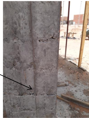
Photo 2.8. Fissure lézard au poteau
