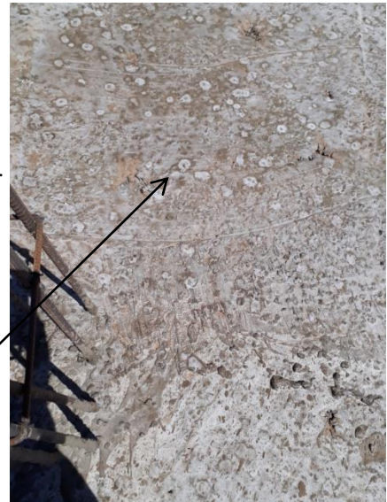
Photo 2.33. Trous et granulats apparents. Photo 2.34. Manque des fines entrainant des bulles
