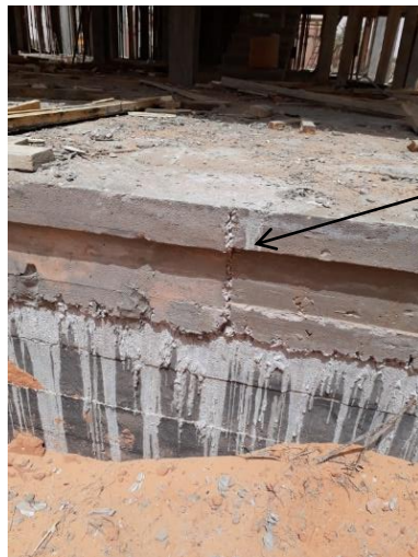
Photo 2.7. Mauvaise jonction du coffrage.
