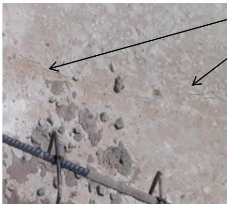
Photo 2.9. Fissure au-dessus de la dalle
