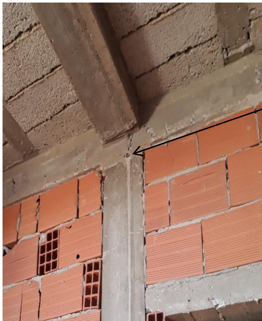
Photo 2.53. Perte de liant entre poteau-poutre. Photo 2.54. Fissure dans la poutre principale.
