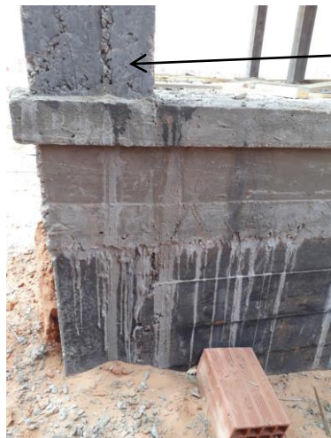
Photo 2.5. Ségrégation en du bas de poteau
