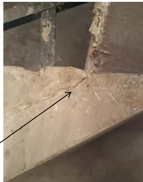
Photo 2.50. L'effet de reprise du bétonnage.
