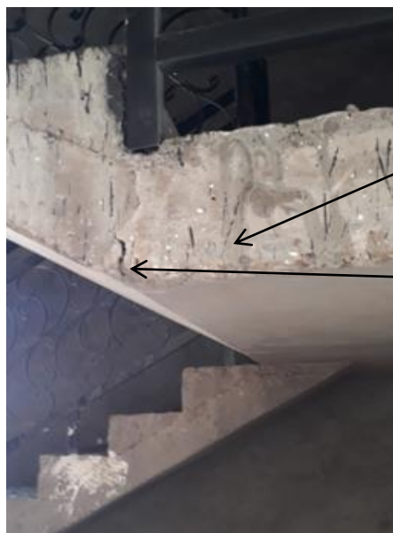
Photo 2.49. Fissure entre palier-paillasse.
