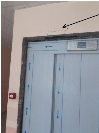
Photo 2.43., et 2.44. Fissure au-dessus du linteau.
