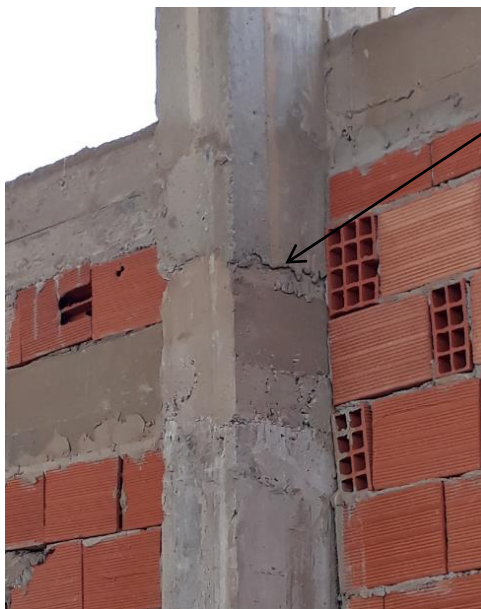
Photo 2.55. Multi-reprise de bétonnage.
