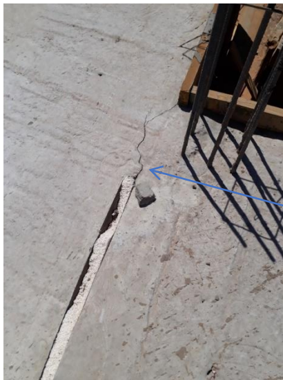
Photo 2.29. Fissure suivant le joint de dilatation. Photo 2.30. Retrait dans le béton du plancher
