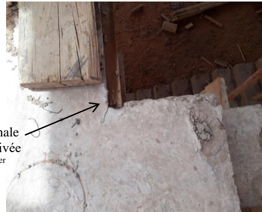
Photo 2.10. Fissure diagonale dans la dalle
