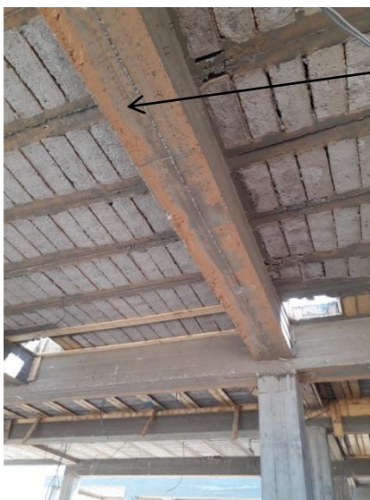
Photo 2.25. Manque nettoyage du coffrage.
