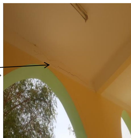
Photo 2.60. Fissuration rectiligne intérieur de l'arcade
