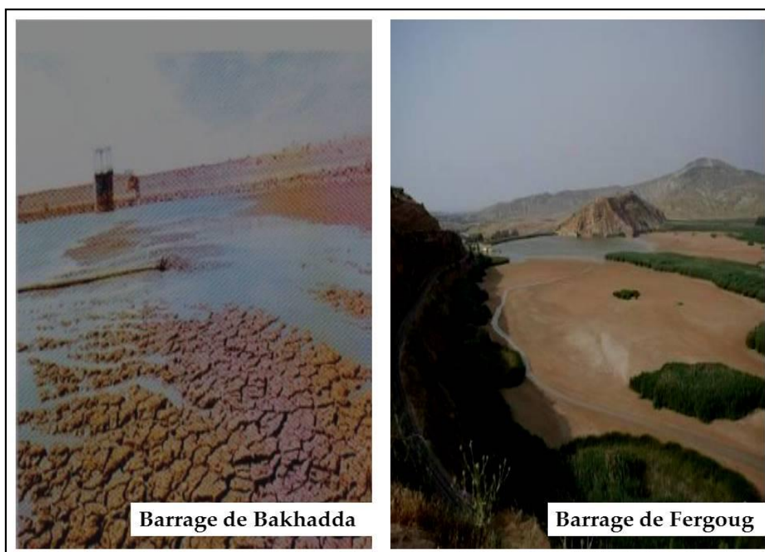
Fig. I-8 : État d'envasement des barrages Fergoug et Bakhadda en 2008.
