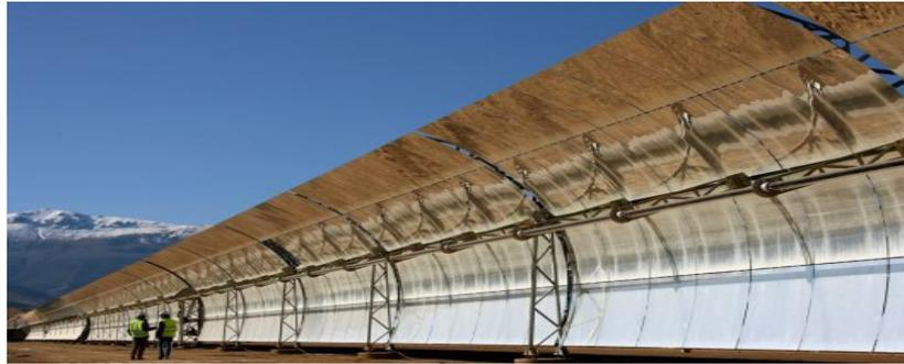
*Figure N°. II.6 : Système à réflecteur cylindro-parabolique. [2]*
