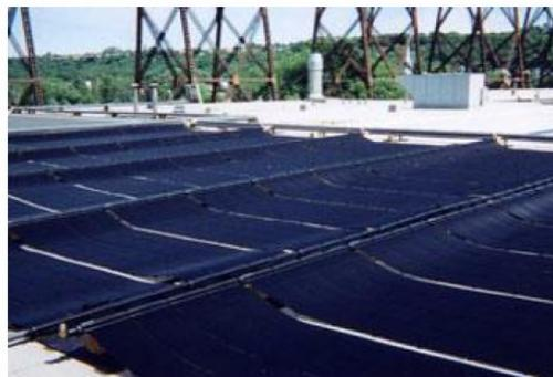
*Figure N°. II.8 : Capteurs solaires sans-vitrage. [9]*
