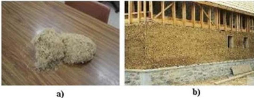
Figure.I.11: Rotin: a) fibres de rotin; b) maison de boue + rotin de fibre. [15]
