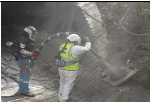
Renforcement des buses métalliques d'assainissement par chemisage à l'aide de la projection de BFM
