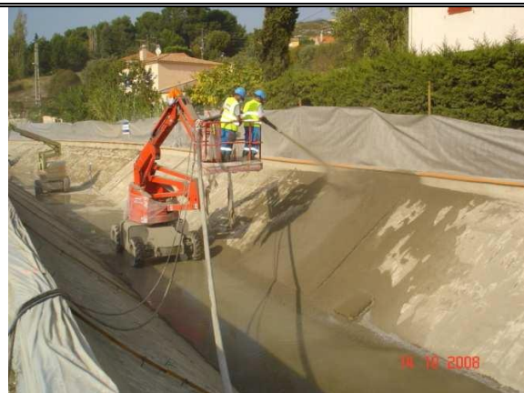
Renforcement des caniveaux des eaux de ruissellement par la projection de BFM
