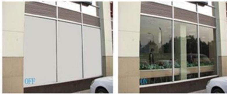
***Figure.34*** Vitrage photochromique : a) vitrage opaque, b) vitrage transparent [23].
