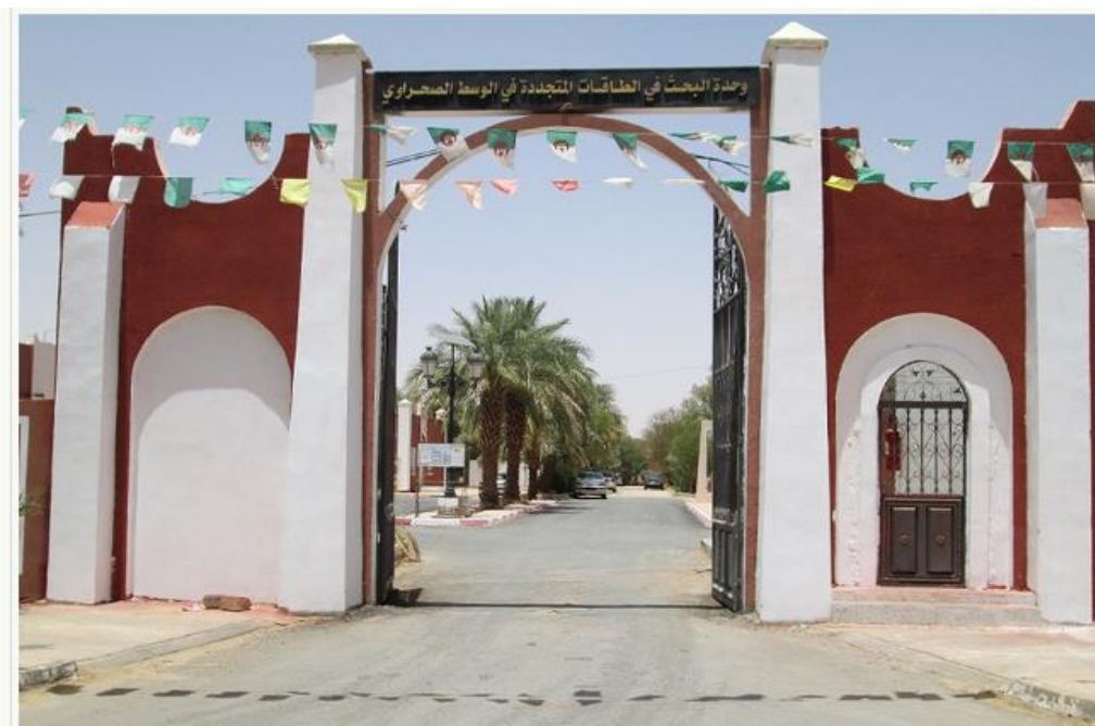
Figure 2- 12 : Unité de recherche en énergies renouvelables Adrar
