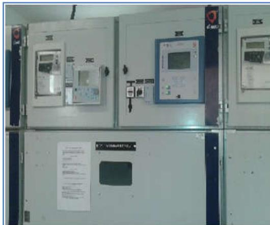
Figure IV.15: cellule (efacec) mt sous-station 30kv éolienne [32].
