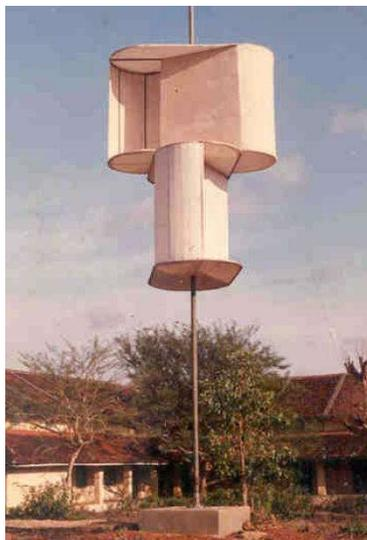
Figure I.3 : Aérogénérateur à axe vertical (structure de Savonius) [9].
