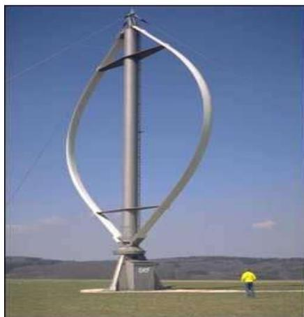
Figure I.4 : Aérogénérateur à axe vertical (structure de Darrieus) [9].
