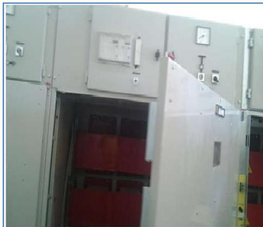
Figure IV.16: cellules (efacec) à mt 30 KV au niveau poste 220/30kv du Kabertene [37].
