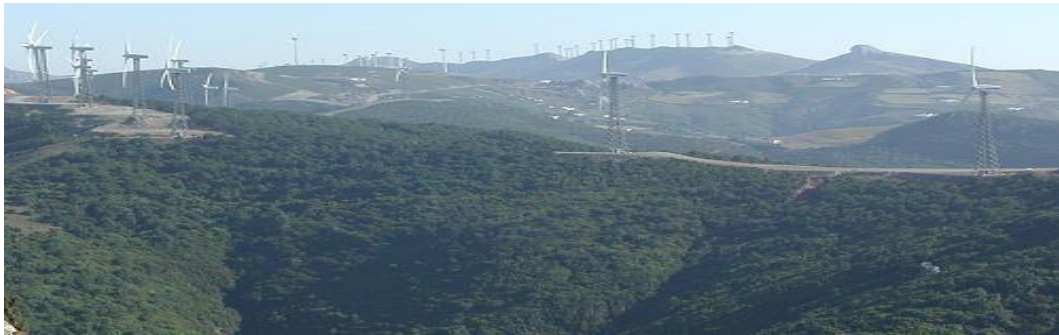
Figure 1.7 Les ventilateurs de production d'énergie éolienne sont installés en hauteur
