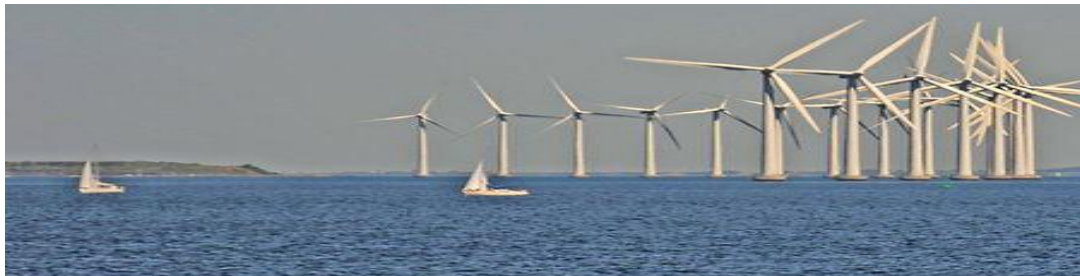
Figure I.8 Des ventilateurs de production d'énergie éolienne sont installés sur la mer
