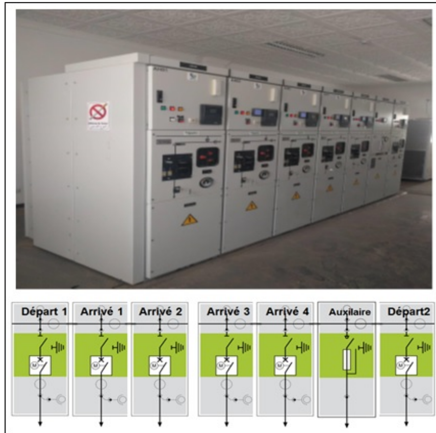
FIGURE 3.11 – Schéma de cellule de la centrale d'Adrar
