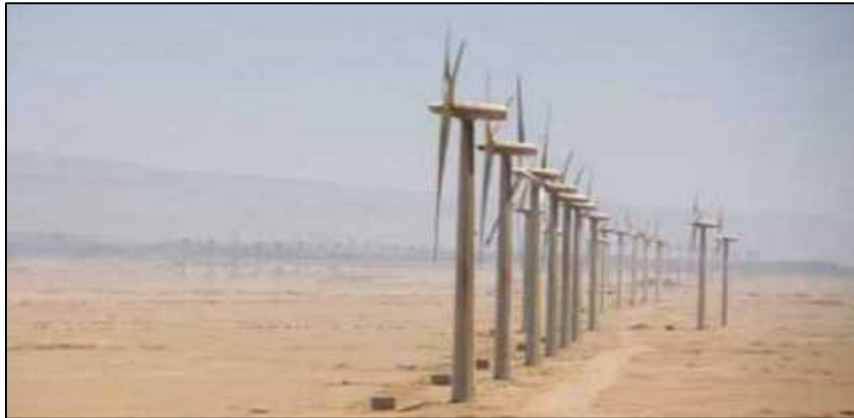
Figure I.10 : la ferme éolienne à Adrar [11]
