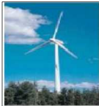
Figure I.14 : éolienne a axe horizontal [8].
