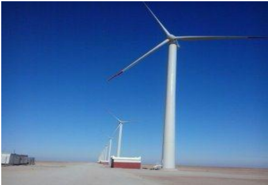
Figure.I.4 centrale d'énergie éolienne d'Adrar
