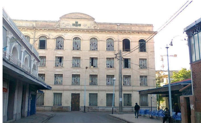
Fig. I. 21 : Vue de façade du bâtiment R+3
