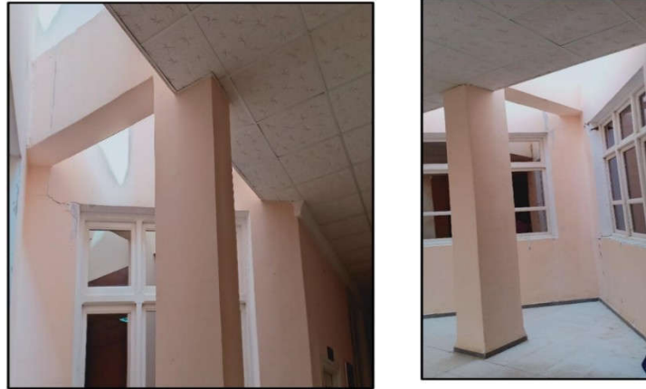
Fig. I.20 : La structure porteuse, jusqu'à maintenant reste non dégradée.
