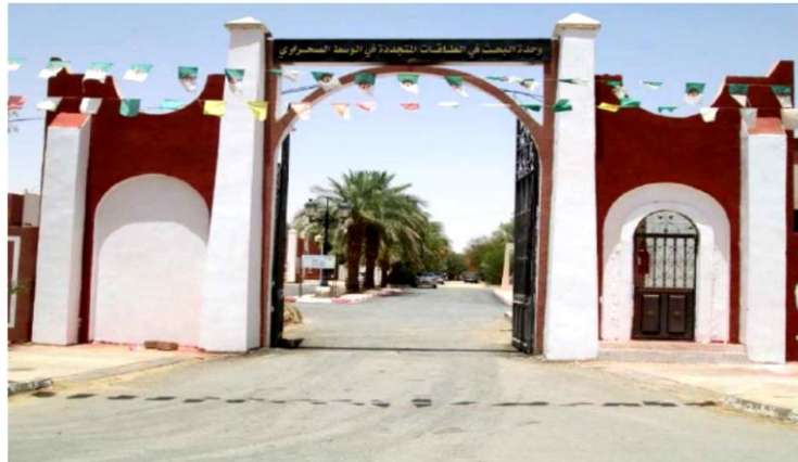
Figure 07 : L'unité de Recherche en Energies Renouvelables en Milieu Saharien-Adrar
