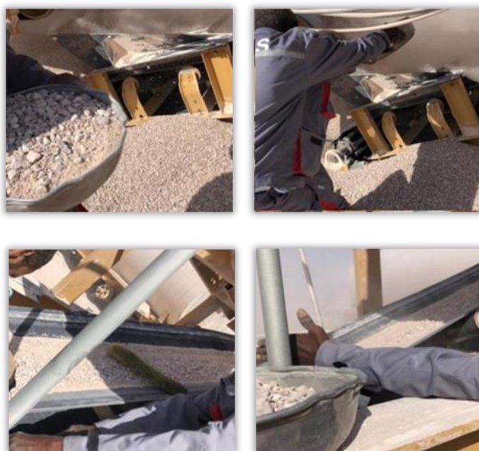
Photo IV.2 : Prélèvements des agrégats mélangés.
