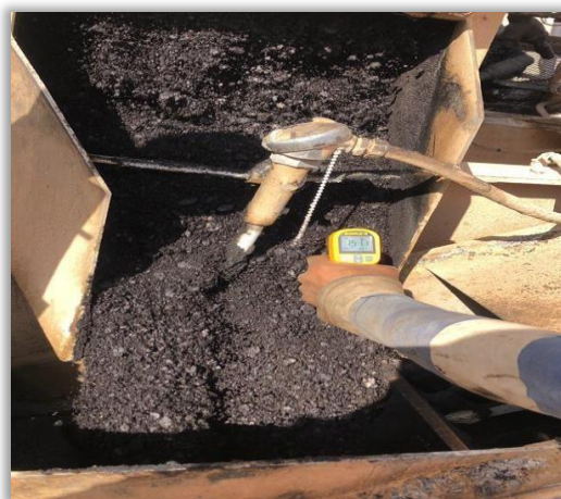
Photo IV.4 : Température de l'enrobé fabriqué.
