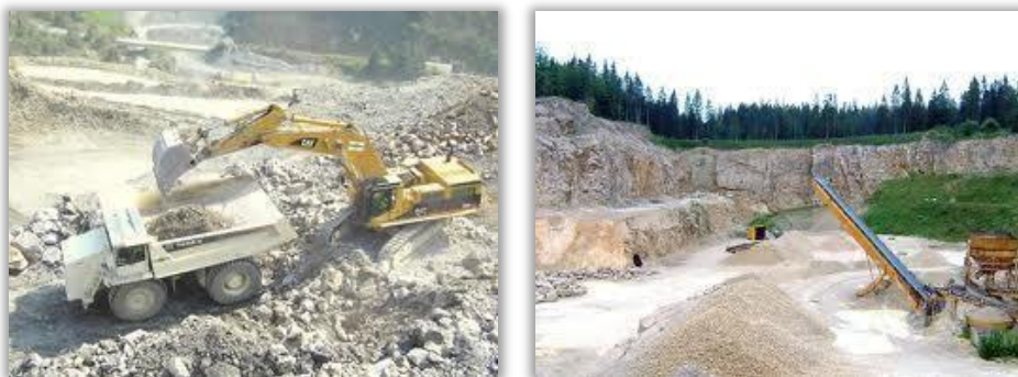
Figure II. 6 : Chantier de concassage des granulats.
