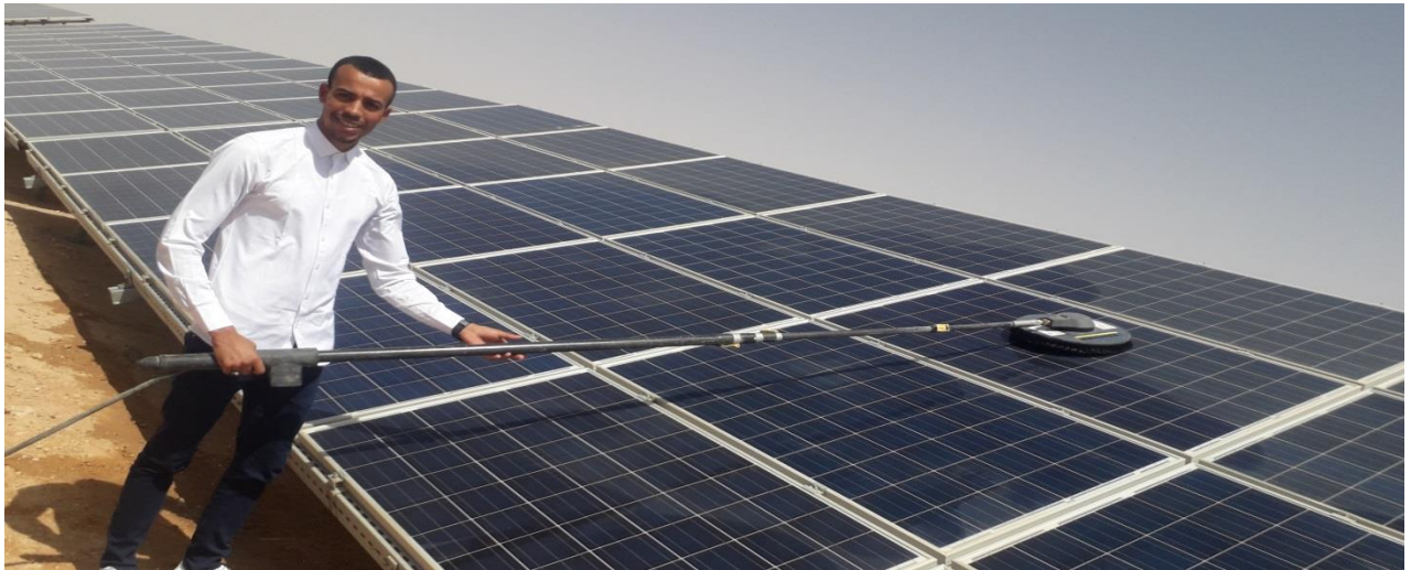
Figure III.35: nettoyage par KARCHER
