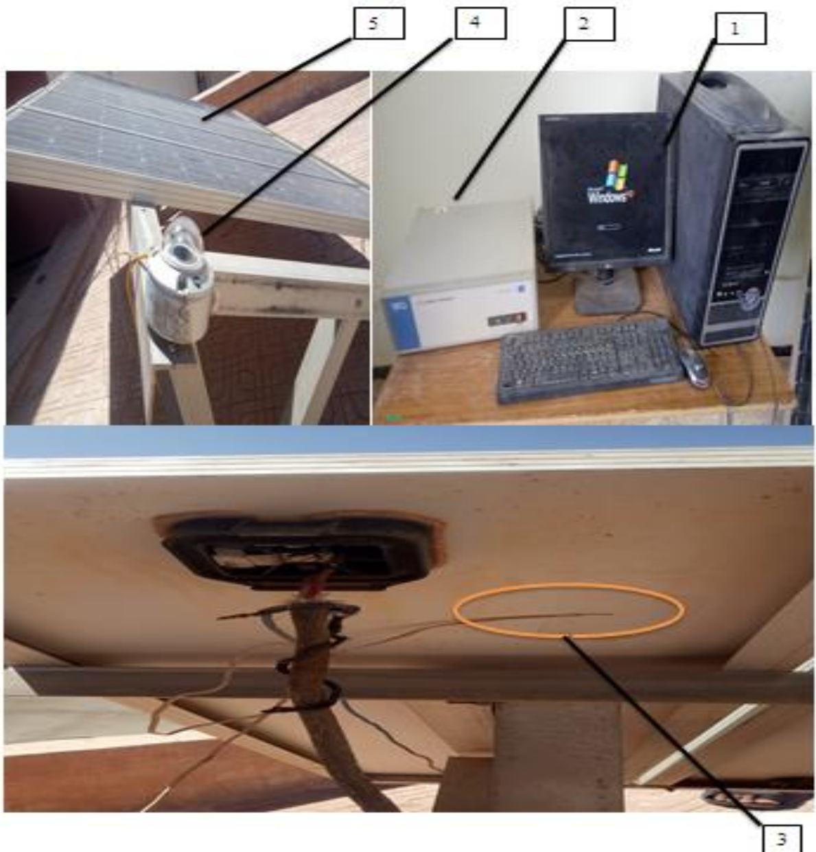
Figure III.12: Plateforme expérimentale : Ordinateur et Traceur MP-160 I-V, Capteur d'irradiance et de température, module PV.
