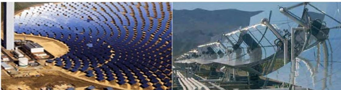
Figure 3. 9 Capteur à chaudière fixe et concentrateur mobile [62]
