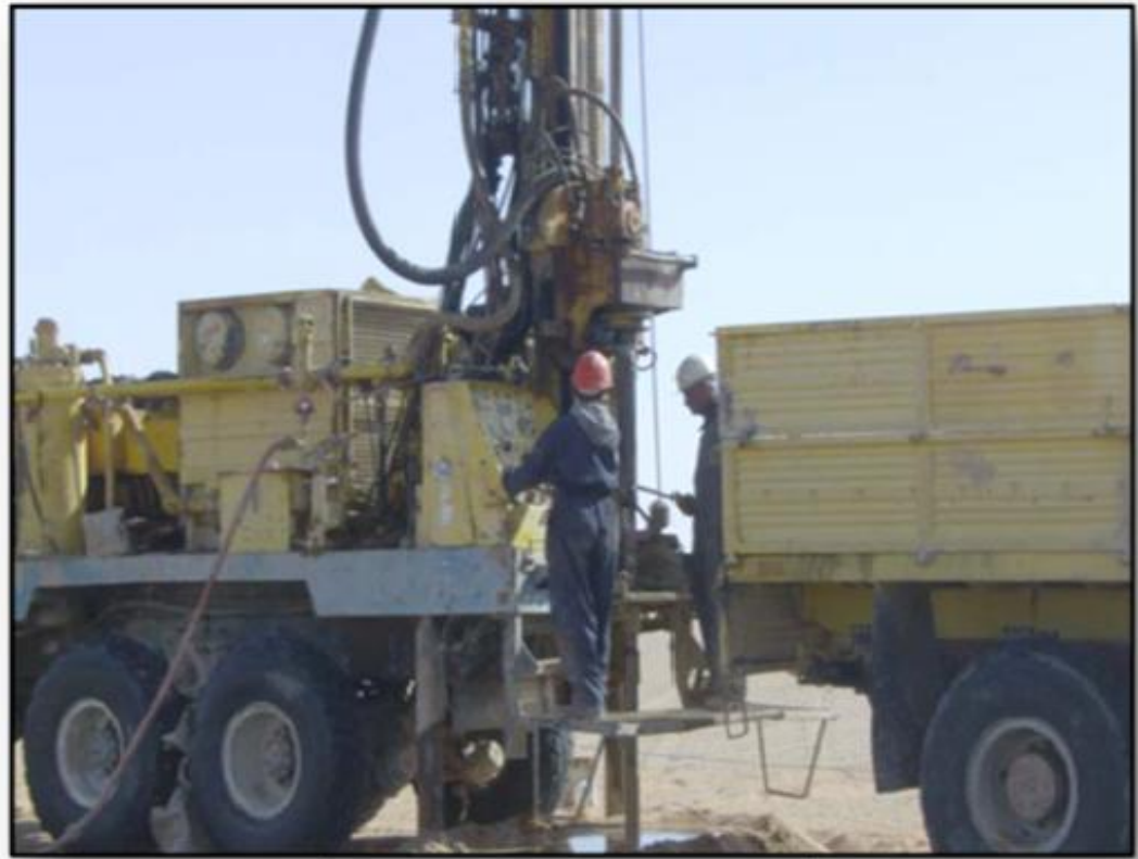
PHOTO 3: Appareil de forage
