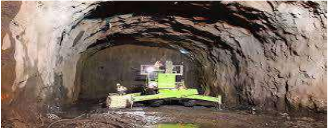
Figure I.4 : Méthode à pleine section [1]
