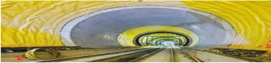
Figure I.14: L'étanchéité du tunnel [13]
