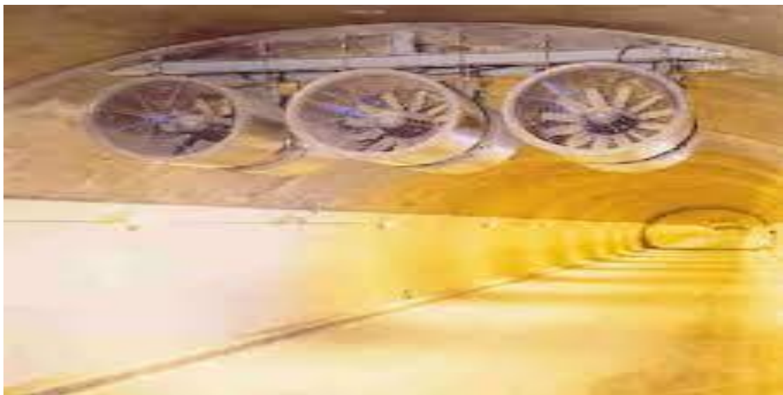
Figure I.17: batterie d'accélérateurs
