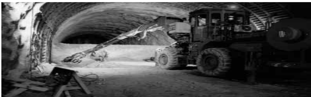
Figure I-5 : Creusement en demi-section [7].
