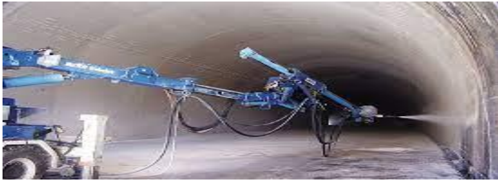
Figure I.11: Le béton projeté [11].
