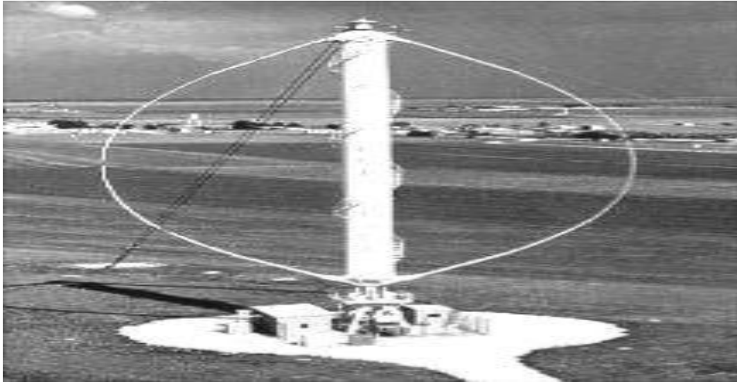
Figure I-13: Schéma du rotor de Darrieus [1].
