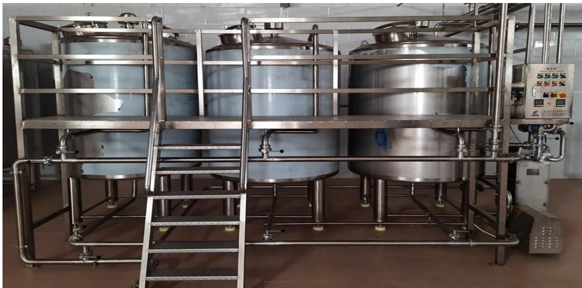
Figure 28: Système de nettoyage et de désinfection automatique (CIP)
