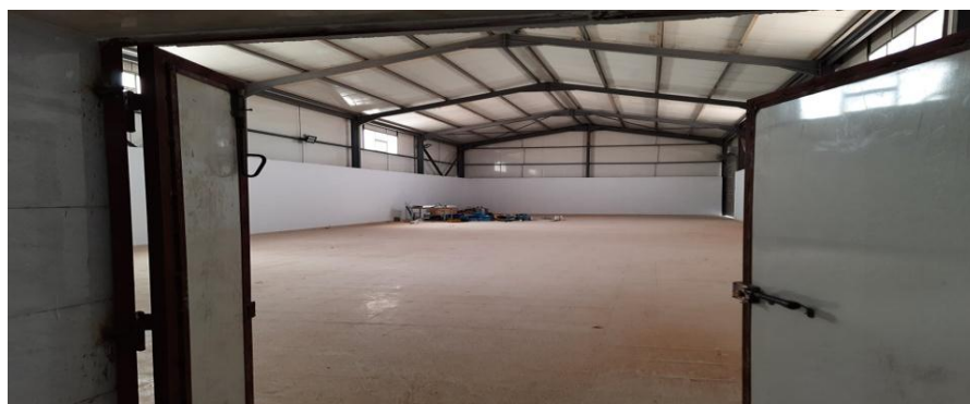
Figure 19: chambre stockage des matières premières
