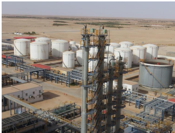
Figure II.44 : Vue générale de parc de stockage
