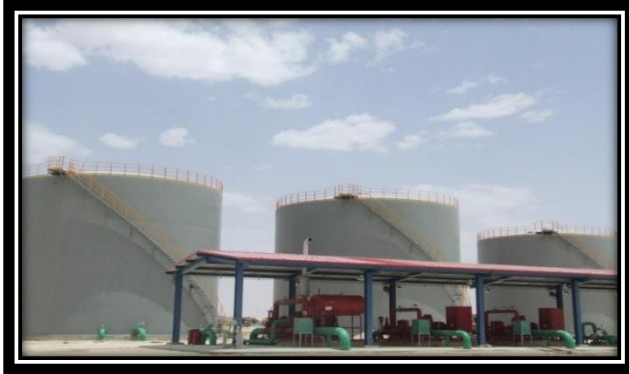
Figure I.6 : BAC d'alimentation d'eau
