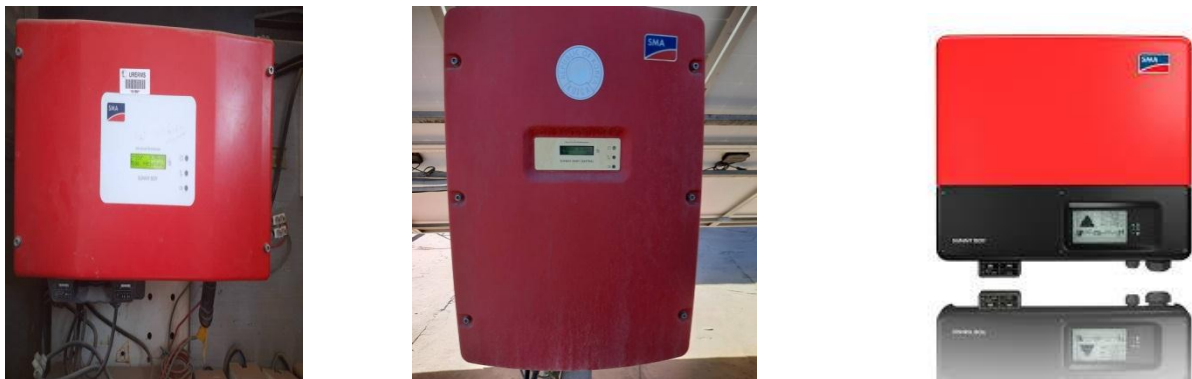
Figure I.11 : Exemple des onduleurs PV
