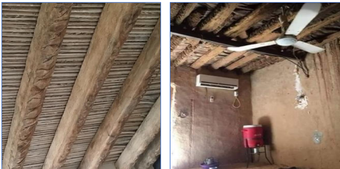
Figure IV. 13: Quartiers de troncs de palmiers forment des supports de toit
