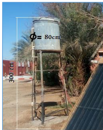
Figure V. 12: Schéma représentant la hauteur piézométrique du bac d'alimentation par rapport au système.
