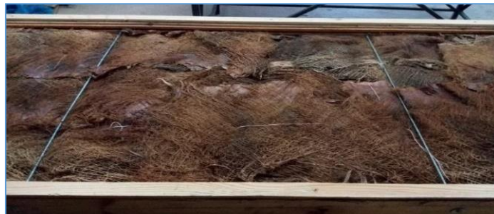
Figure V. 5: Structure de caisson en photo avec des tiges de renforcement.
