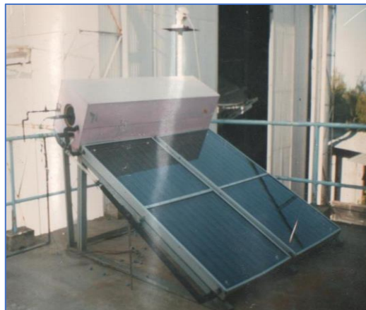
Figure II. 3 : Configuration d'un chauffe-eau solaire cuve séparer
