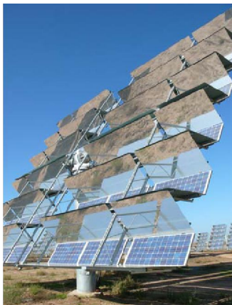
Fig. 2.35 - Système LCPV Abengoa Solar. 154 unités : 1 MWc DC (STC). Photo [97].
