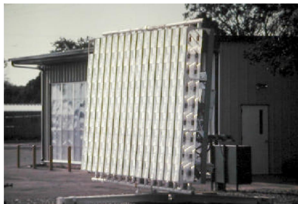
Fig. 2.7 - Le générateur SANDIA II, le premier système CPV moderne 32X. Albuquerque, Mexique, en 1977.
