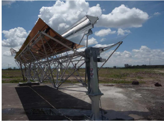
Fig. 2.32 - Système CPV de la technologie Skyline Solar de suivi un axe. Photo [96].
