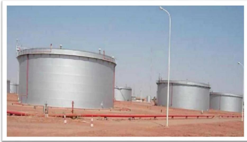
**Figure I.05.** Réservoirs à toit flottant
