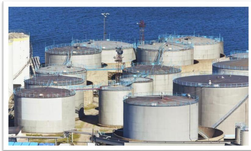
*Figure I.17.* Les réservoirs à simple intégrité [07]
