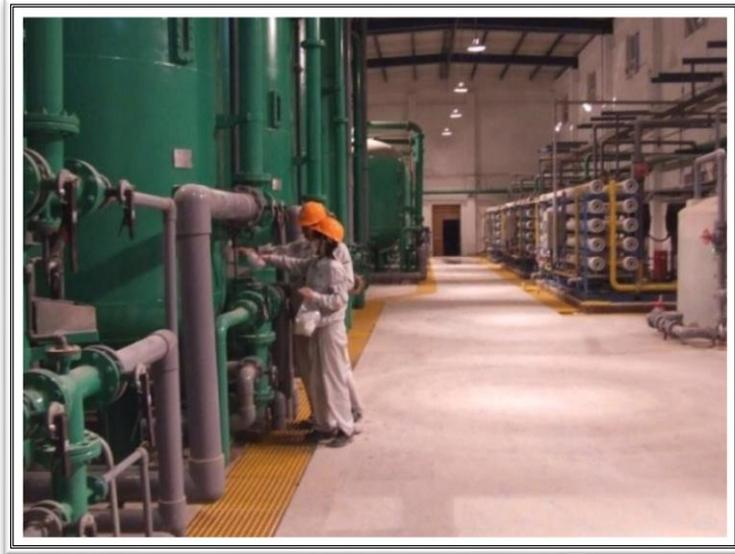
**Figure II.16.** Filtration par osmose inverse
