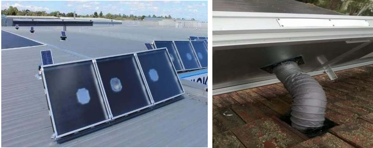
Figure.I.16 : Système solaire hybride à air PV/T [19]
