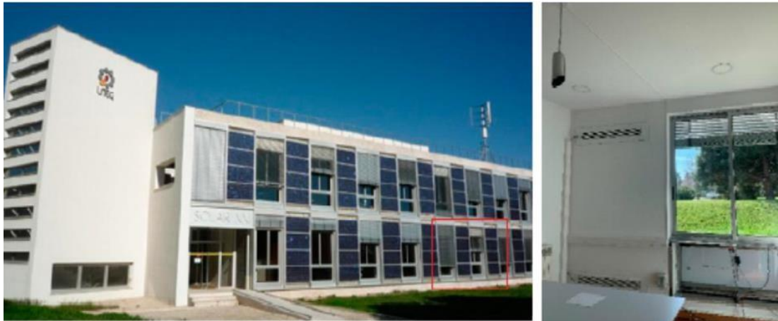
Figure.I.23 : Emplacement de la salle d'essai dans le bâtiment solaire [41].
