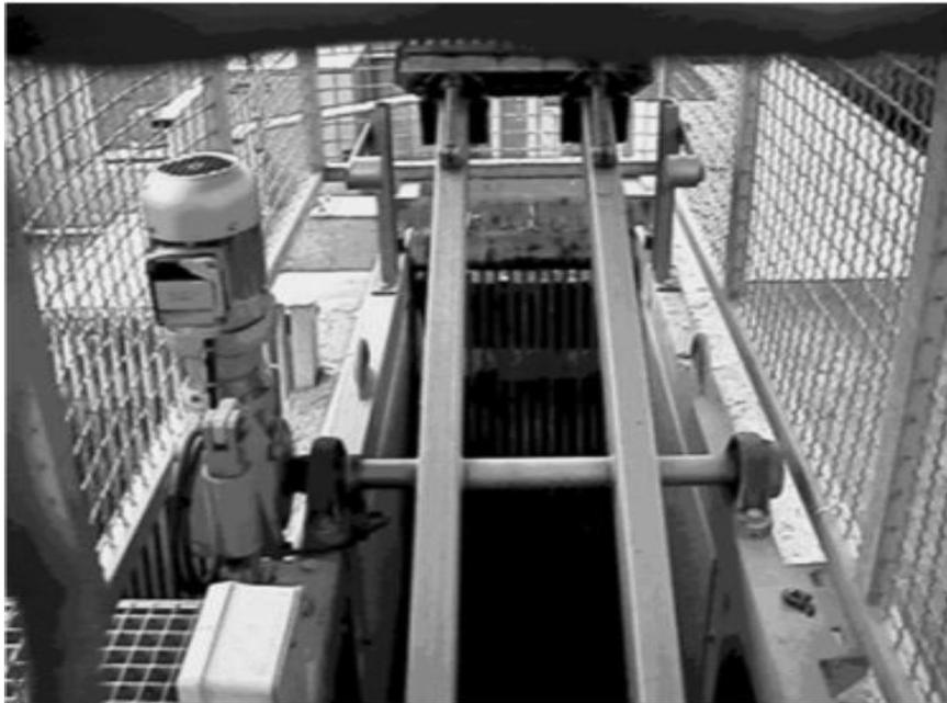
**Figure 3** Degrilleur mécanique [26].
