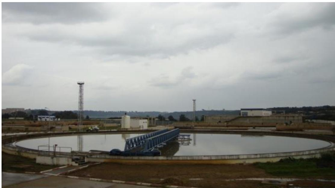
**Figure 6** Décanteur circulaire [28].
