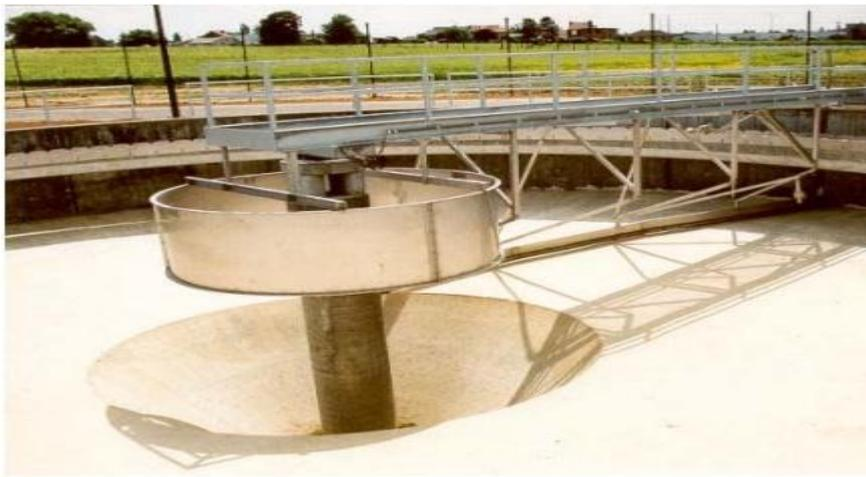
**Figure 5** Décanteur primaire avec pont racleur a engrainement périphérique [27].
