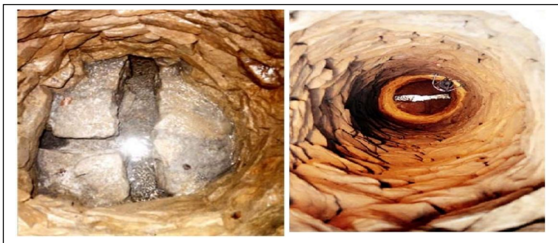
Photo 1 Vue aérienne d'un puits appartenant à l'aqueduc souterrain des Raschpötzer (27).
