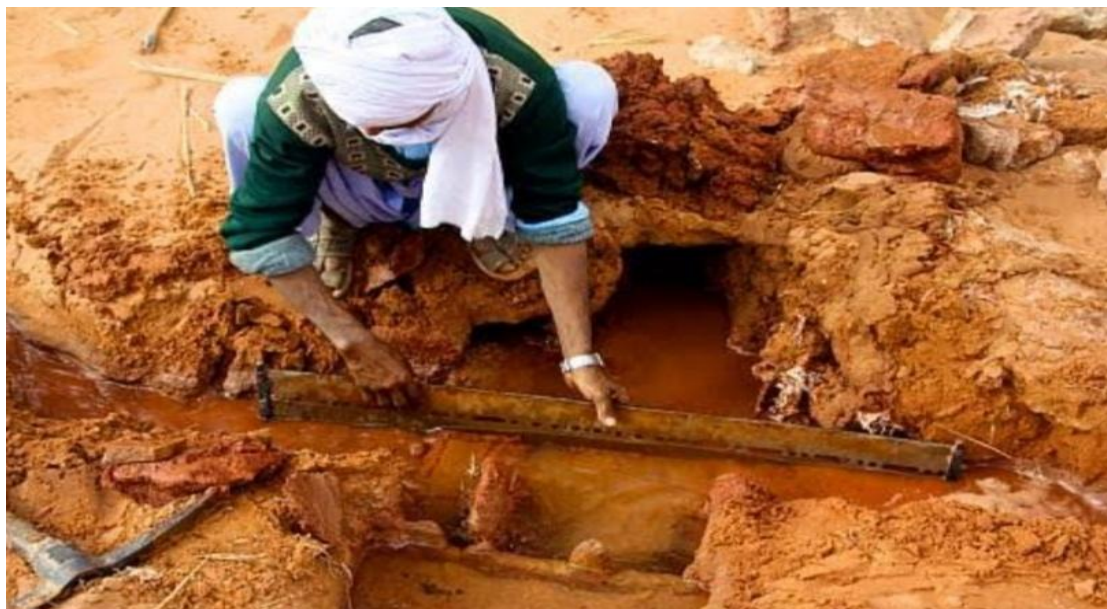
Photo 8 Emplacement de "Chekfa" pour la répartition d'eau des foggaras "Kiel al ma" (35).
