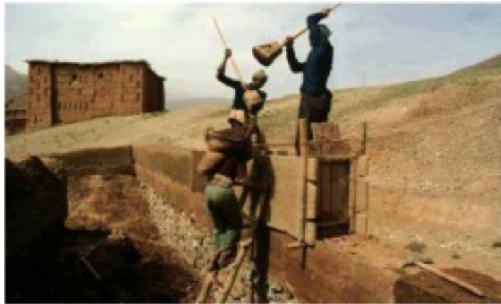
Photo L3 : Technique de production de pisé(Le Maroc) [27].
