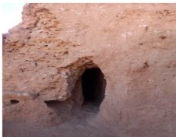
Photo I.9: un enduit en terre (Système d'agharaf) dans un Kssar d'Adrar(Tamantit)(auteur).
