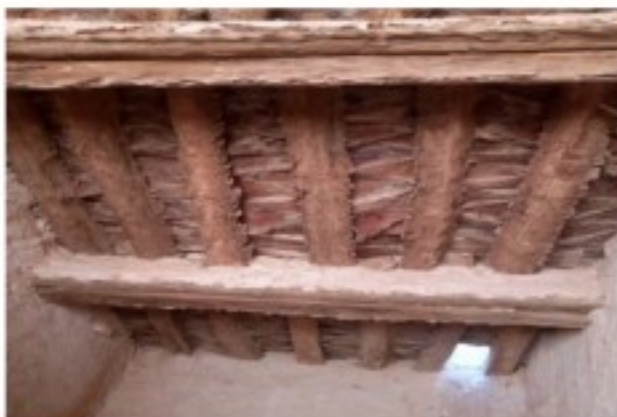
Photo I.8: un plancher avec les palmé et la terre dans un Kssar d'Adrar(Tamantit)(auteur).
