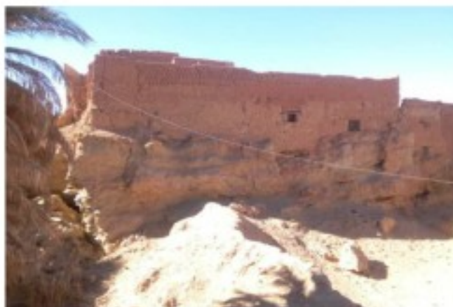
Photo L11: Le Fondation sur de sol Tafza d'un Kssar d'Adrar(Tamantit)(auteur).
