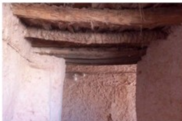
Photo I.9: un enduit en terre (Système d'agharaf) dans un Kssar d'Adrar(Tamantit)(auteur).
