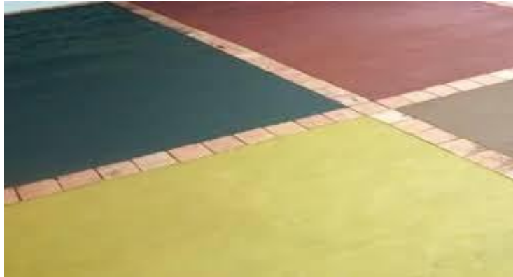
Figure48 : réalisation béton d'argile
