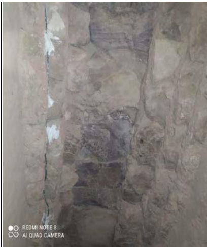
Figure30 : Toiture de couloir en pierres
