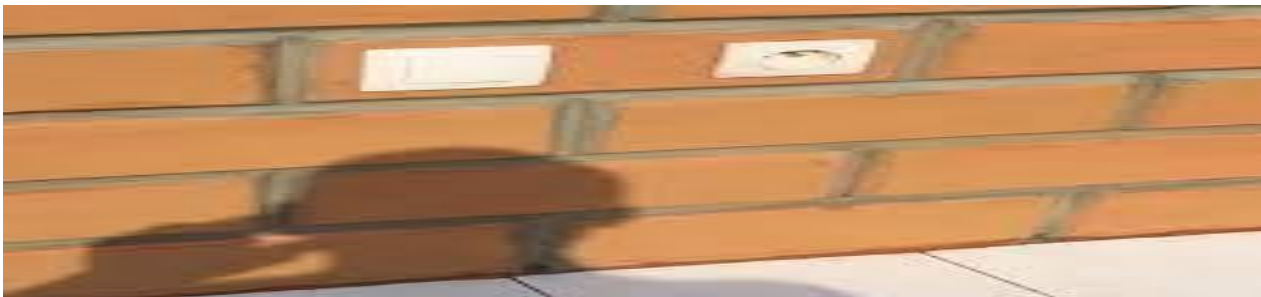
Figure44 : mur en brique de terre stabilisée (data:image/jpeg;base64)
