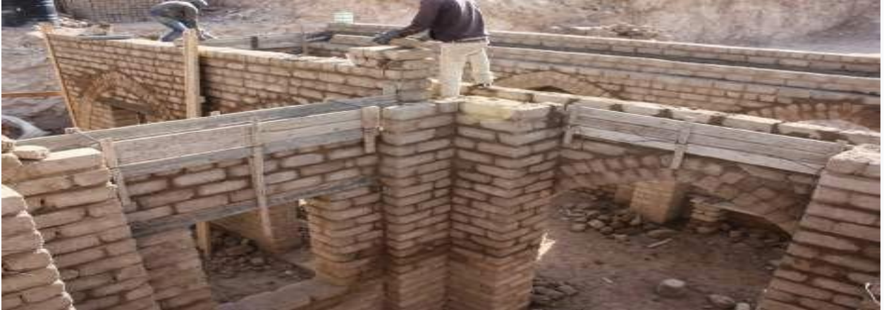
Figure34 : La photo montre la maçonnerie avec des briques pressées( http://f13f.blogspot.com/2014/07/blog-post.html )
