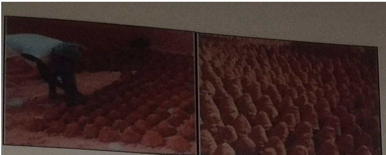
Figure 10:les briques d'adobe façonnées (source: "bâtir en terre ",p44)
