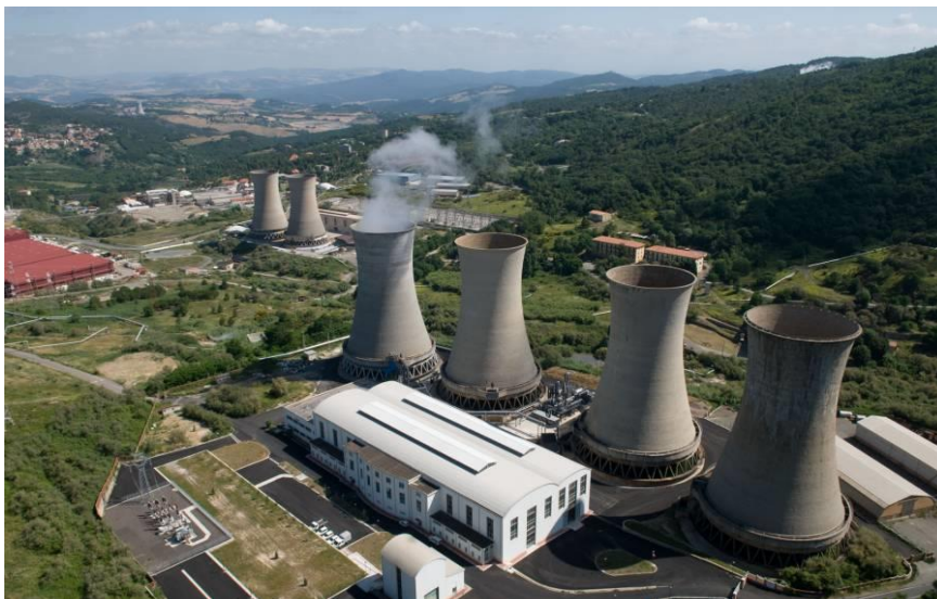
Figure I.2: centrale géothermique Enel(Italie)
