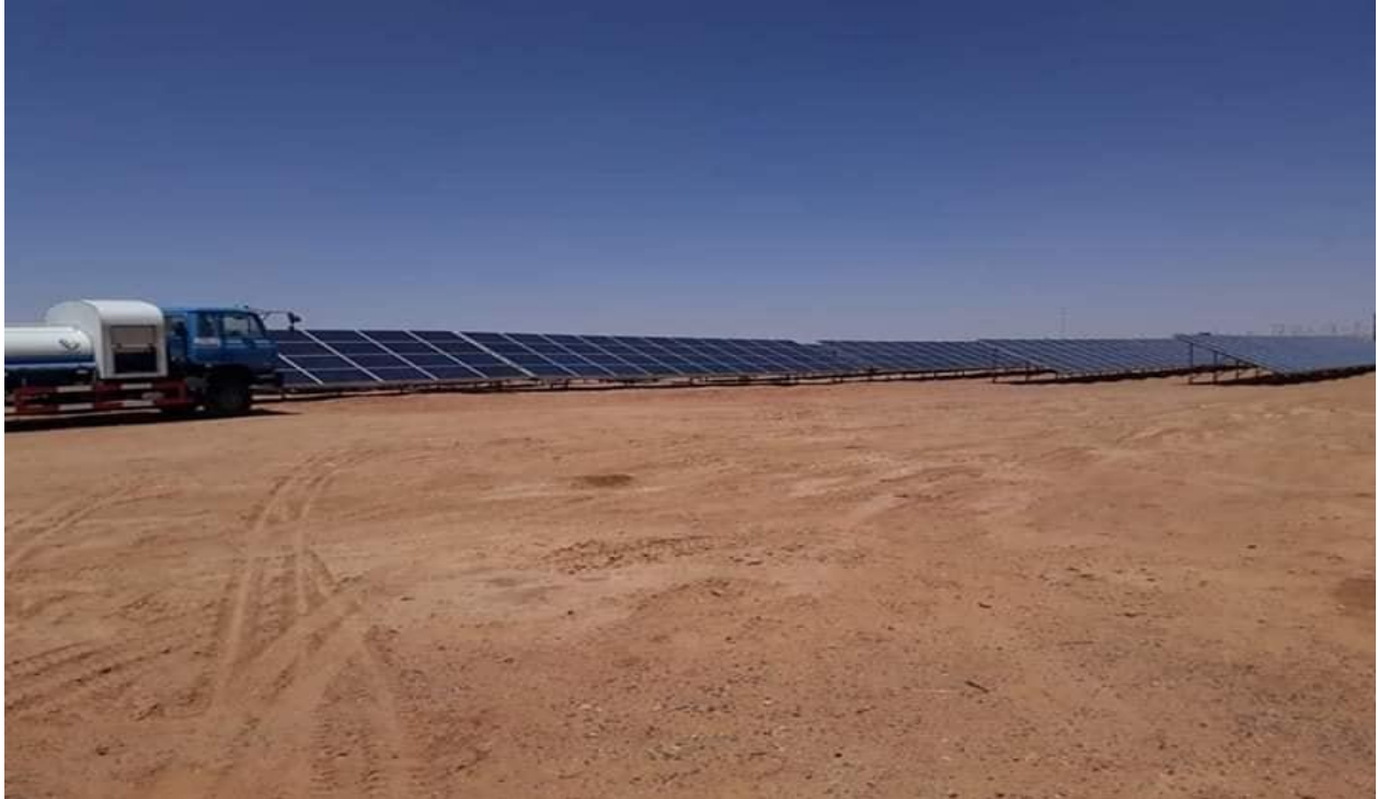
Figure. I : Champs photovoltaïques de centrale PV de Zaouiet Kounta.
