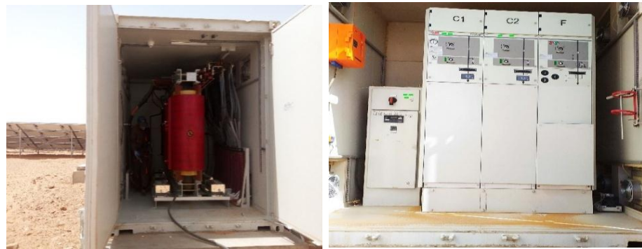
Figure.II.15 : L'intérieur de transformateur.
