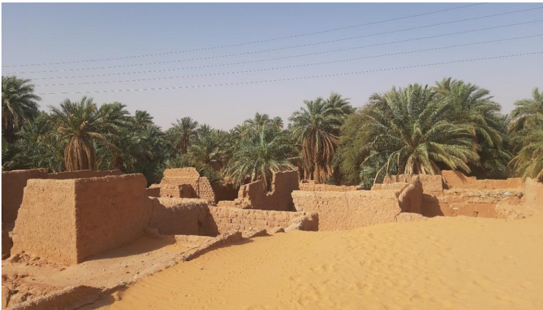
Figure n°07 : vieilles maisons abandonnées sous les dunes de sable.
