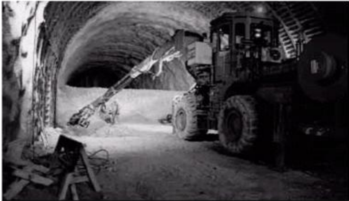
Figure I-4 : Creusement en demi-section [3].
