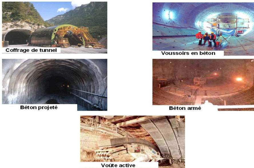
Figure I. 11 : Différents types de soutènement, revêtement [2 ]
