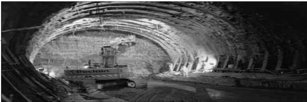
Figure I.3 Creusement en pleine section [3].
