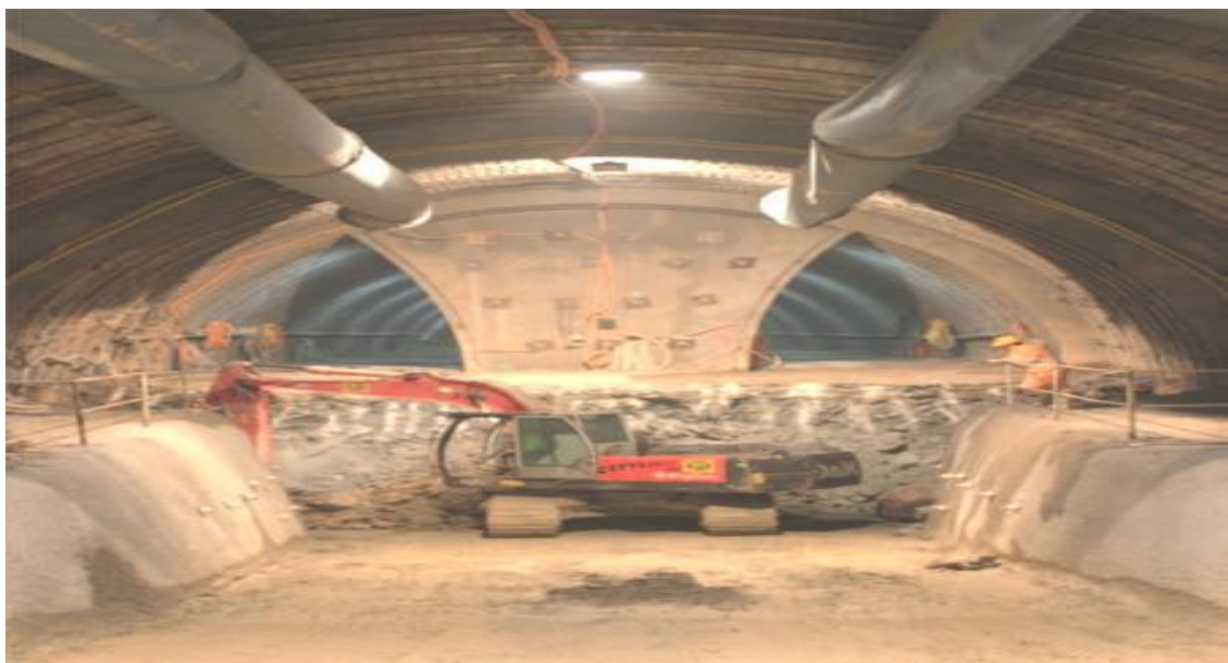
Figure I.5 : Creusement en section divisée [6]
