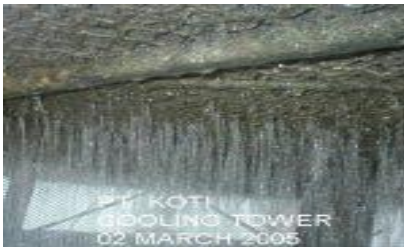
Figure II.8 : Les proliférations organiques dans la tour ( Bekhadouma et Benali, 2014 ).
