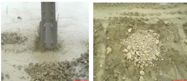
**Figur II.7:** Finition d'une colonne (*Site : barrage Kissir- Jijel*)
