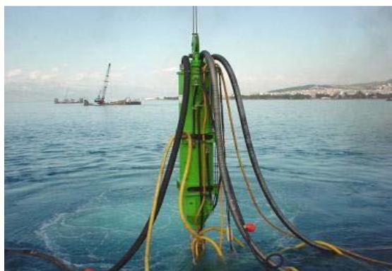
**Figur II.10:** Exemple d'un système en double sas (*Document de Soletanche Bachy*)
