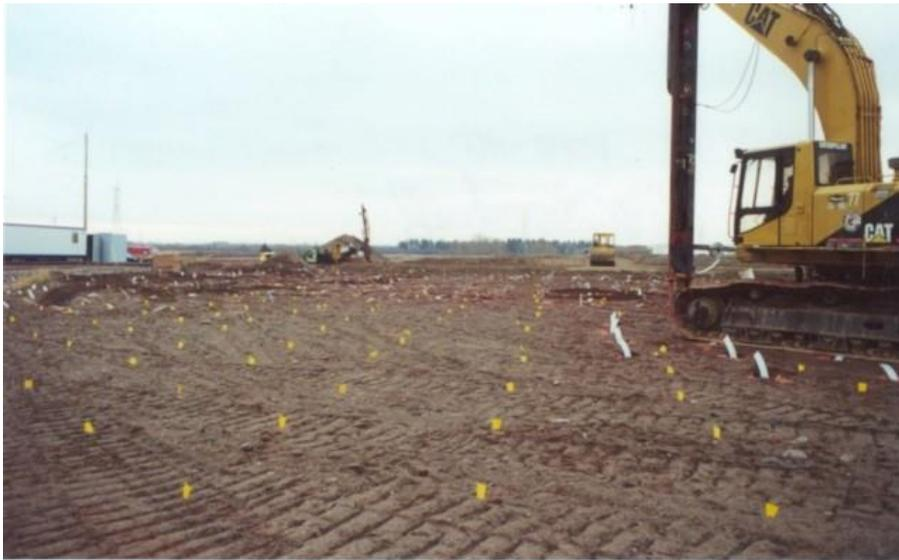
**Figur I.2:** Chantier de réalisation des drains verticaux (*Document de Géopac®*)
