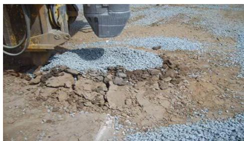
**Figur II.2:** Finition d'une colonne (Site : mosquée de Boudouaou)
