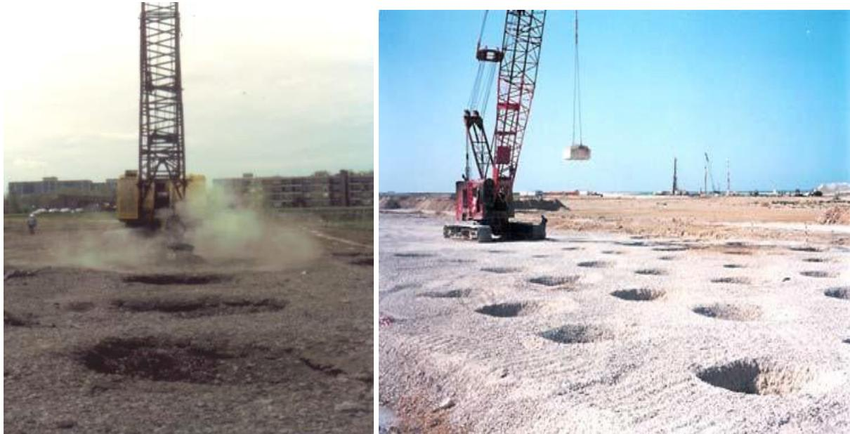
**Figur I.3 :** Exemples de chantiers de compactage dynamique (*Documents de Géopac® et Ménard Soltraitement®*)
