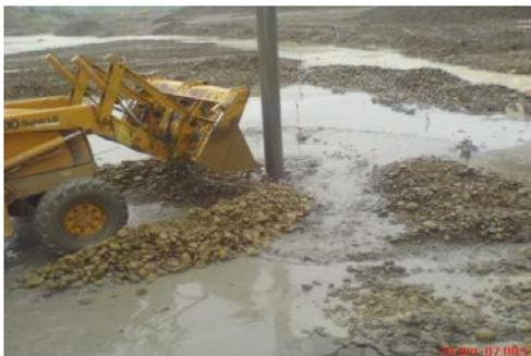
**Figur II.6:** Remplissage du trou par le ballast (*Site : barrage Kissir- Jijel*)
