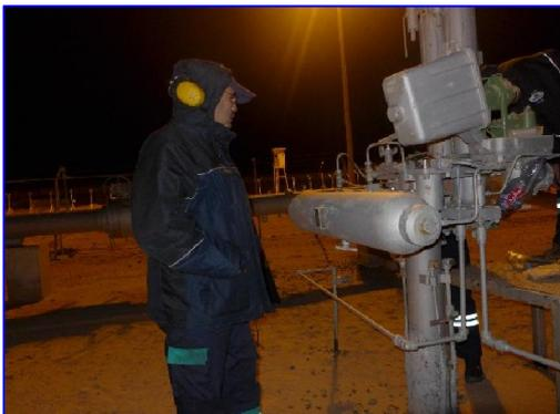
**Photo 09 II:** Fermeture des vannes Ø12", Ø4" et la vanne automatique
