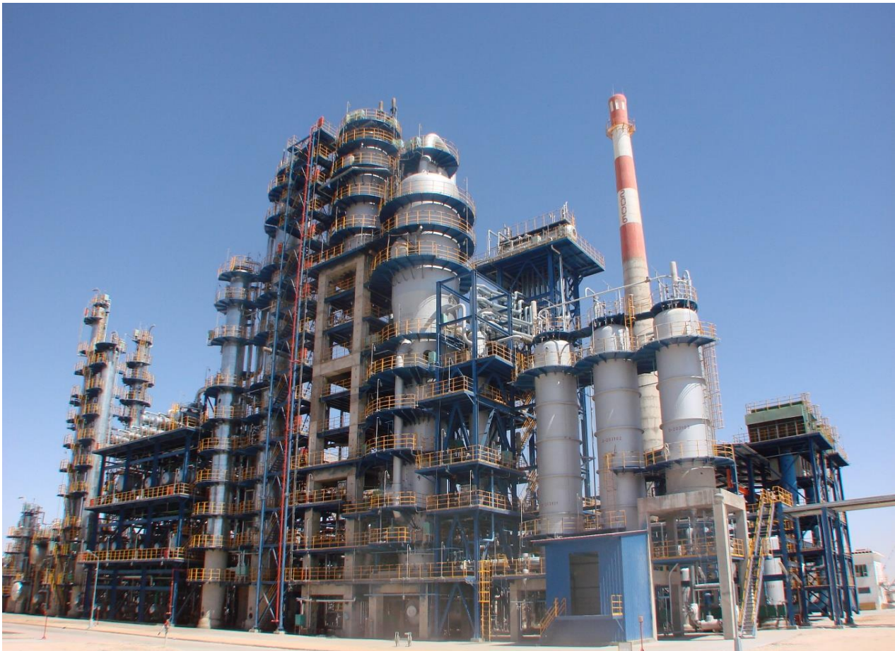
Figure III.1. Vue partielle des sections Réaction/Régénérateur et Fractionnement.
