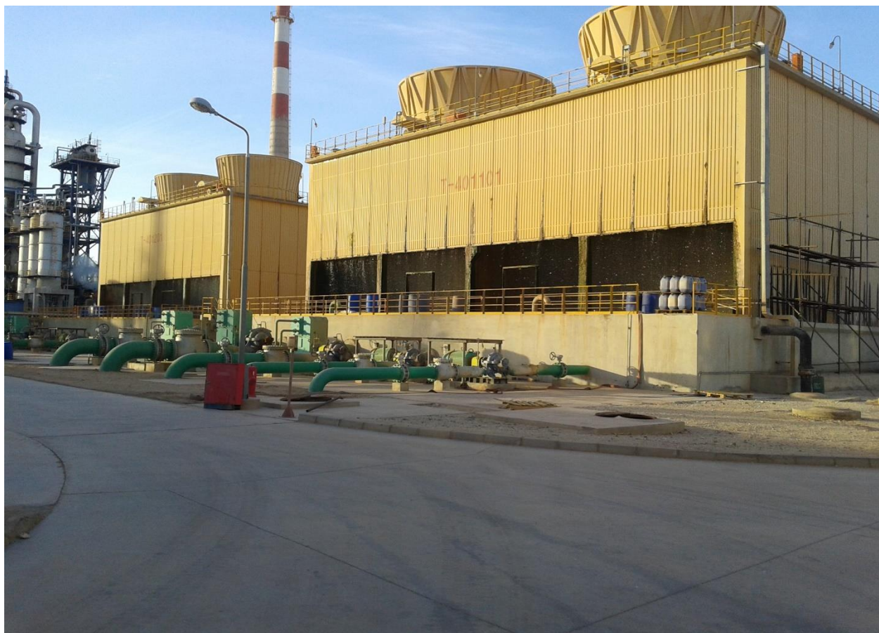
Figure I.4. Section de refroidissement de l'eau.
