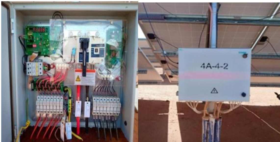
Figure(III-5) : Boit de Jonctions
