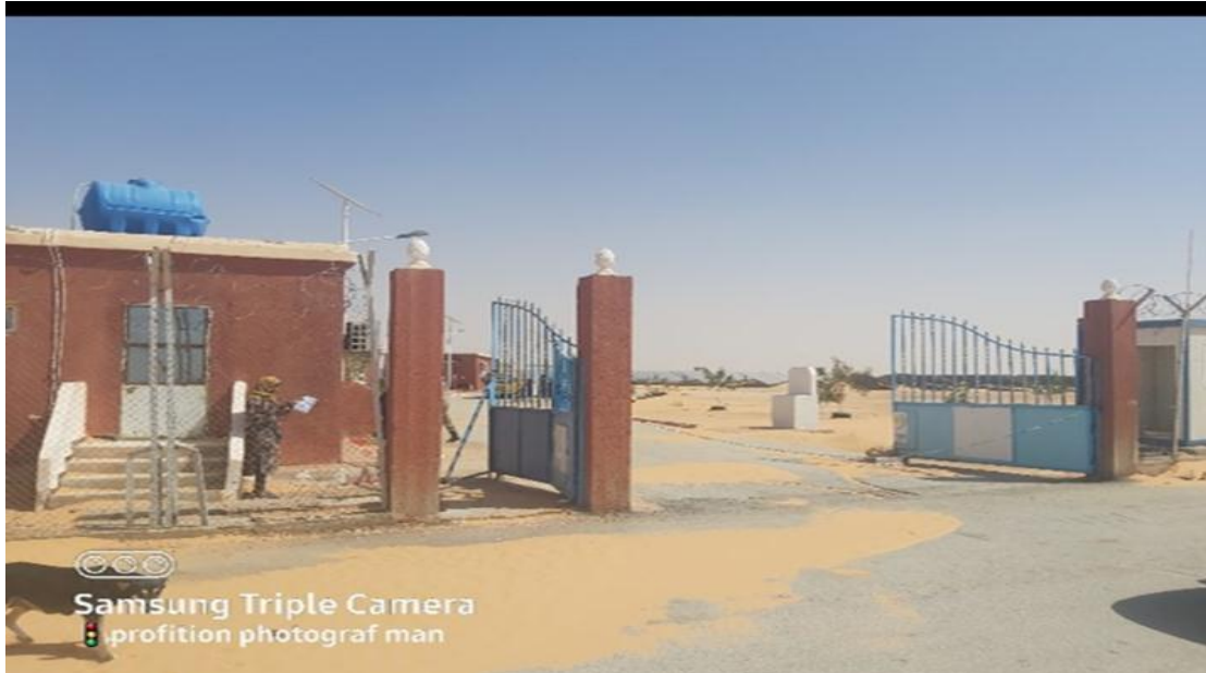
Figure(III-3) : Centrale PV d'Elwajda Timimoune
