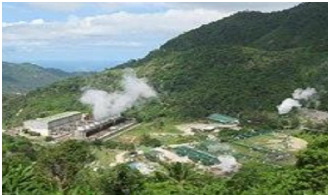
Figure I.15: La centrale géothermique de pinon pinon (philippines), le plus profond puits est de 3800 m [34]
