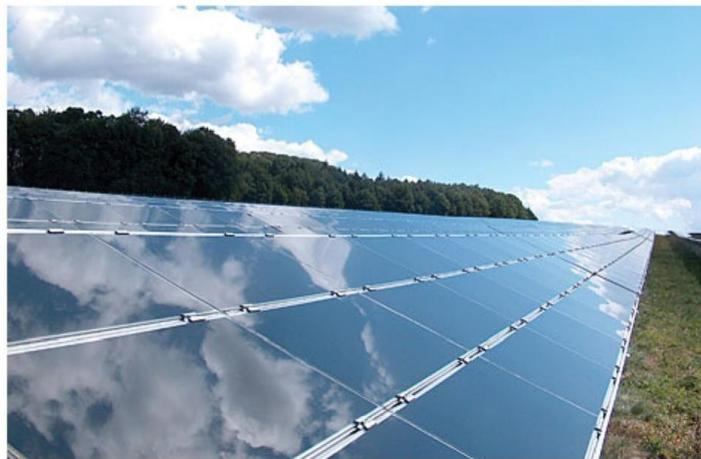
**Figure (II-5): Modules verre-verre au Telluride de Cadmium, efficacité de 9 à 11%**
