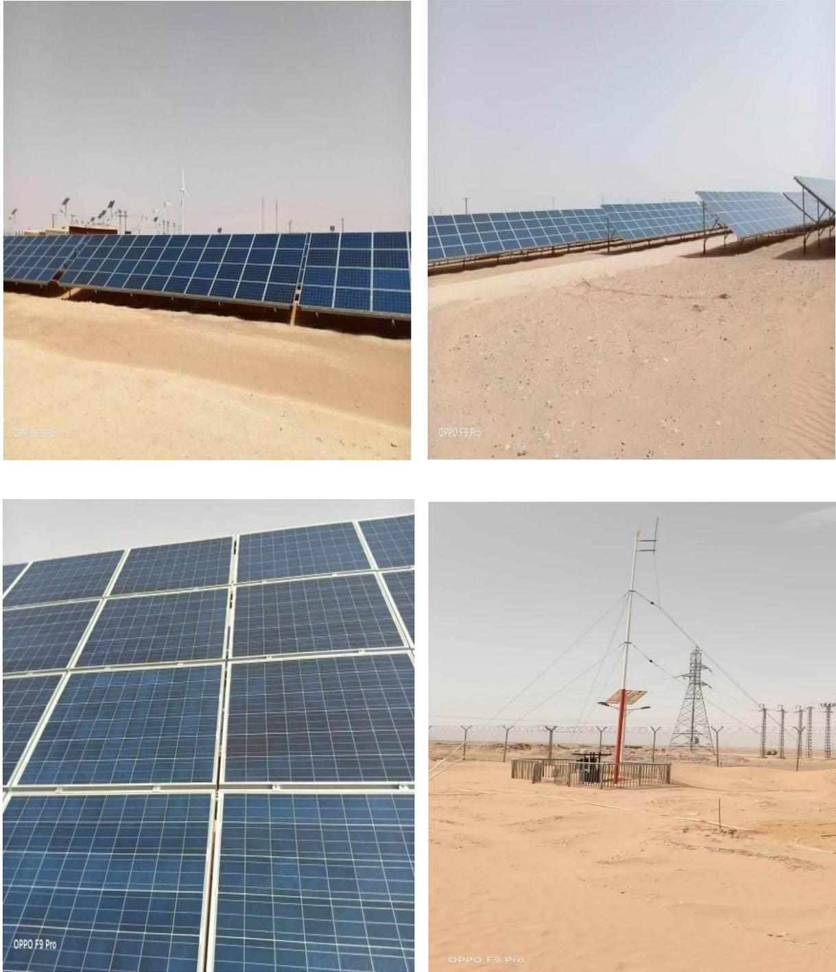
**Figure (III-4) : Photos de la centrale photovoltaïque de Kabertène ; le champ PV et la station météorologique.**
