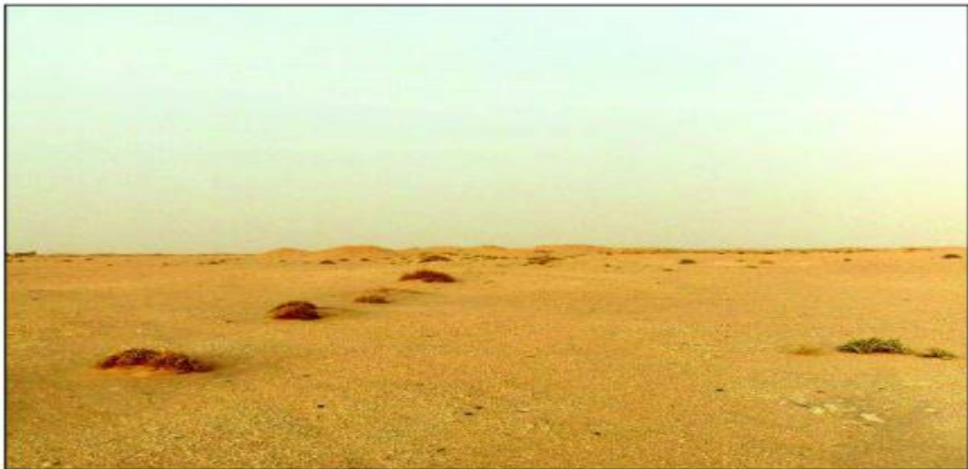
Figure 8. Puits de Foggara effondrés et entièrement ensablés. [31]
