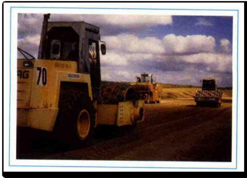
Figure II.11 : Compactage par l'utilisation de rouleaux vibrants à pieds
