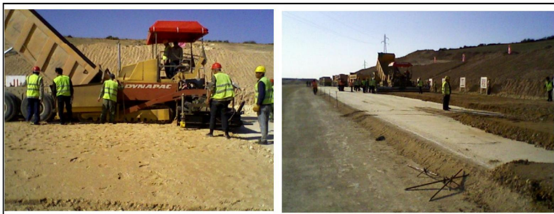
Figure II.9 : Planche d'essai en tuf traité préparé en centrale (L'Autoroute Est-ouest, tronçon Oued Tlelat - Sig)
