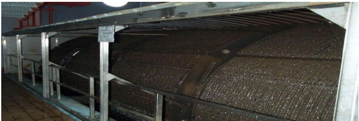
Figure 15: disque biologique (Sirven 2006)
