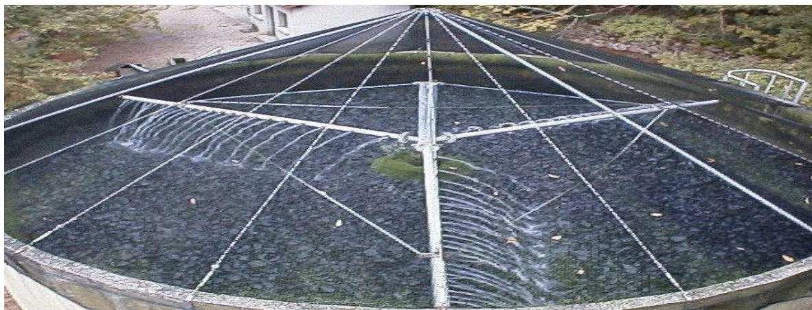
Figure 13: lit bactérien (C Boutin et al. 2017)
