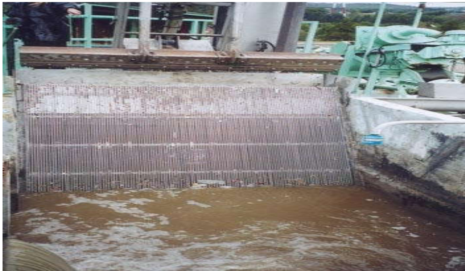
Figure 8: dégrilleur (Bahlaoui et al. 2012)
